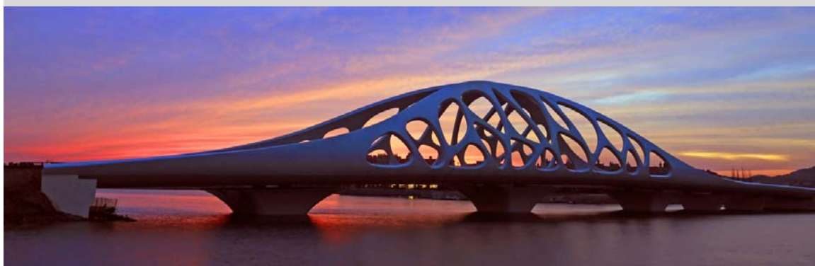
标志性景观桥——青岛西海岸珊瑚贝桥
